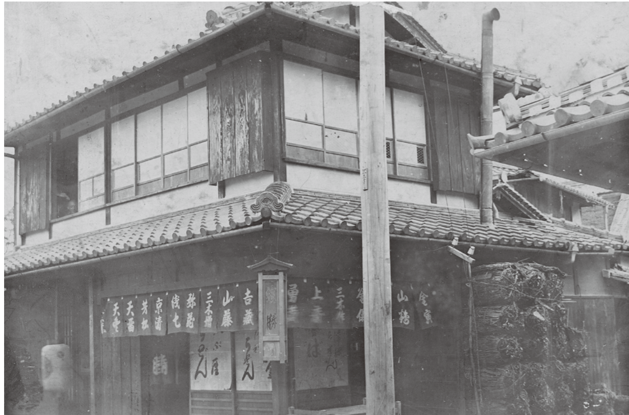
創業前の建物(うどん屋):辰次郎が創業する前は、うどん屋を営んでいた。軒下にかかる行燈には、屋号「濱勝」と書かれており、吹田市濱之堂の大枝勝次郎(辰次郎の父)が営む店であったことがうかがわれる。
