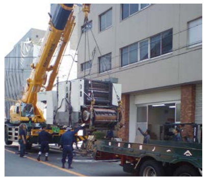
工場移設工事
