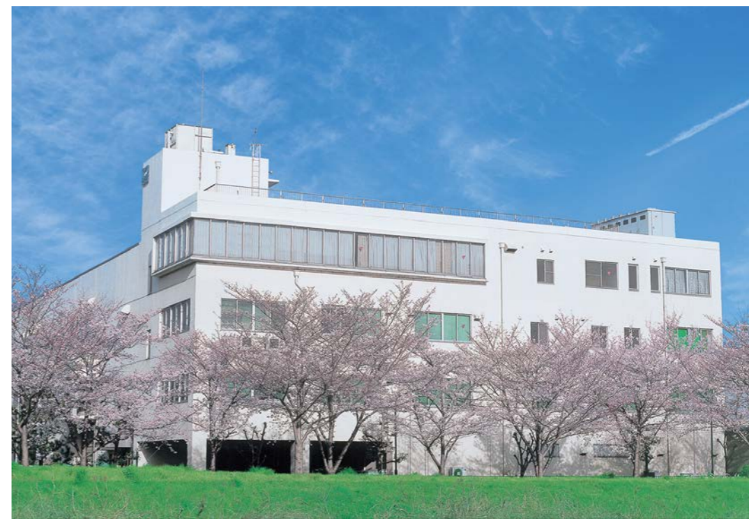
大阪工場外観(富田林)
