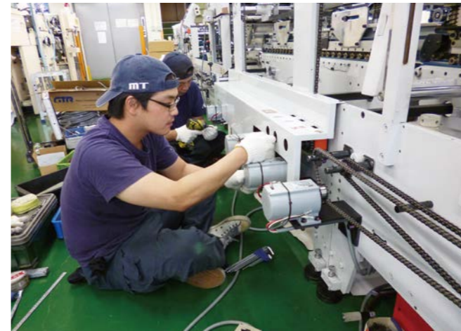
サクマシ改造工事
