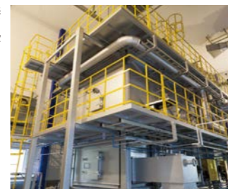
滋賀工場 第二事業所バイオマスボイラー
