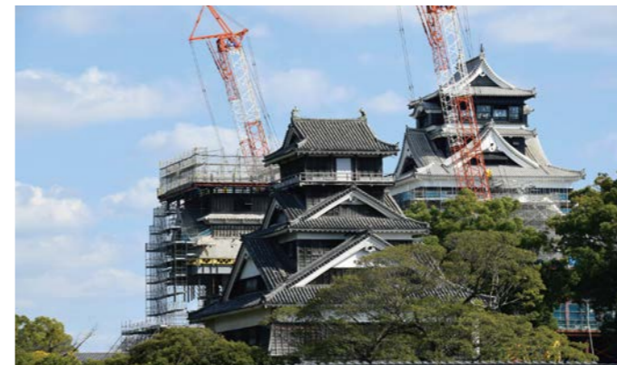
修復中の熊本城
